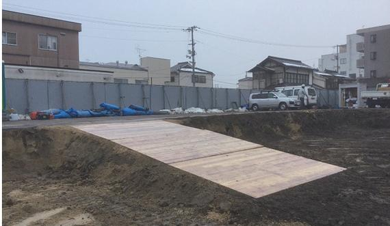
写真7 CLT材による敷き木板
