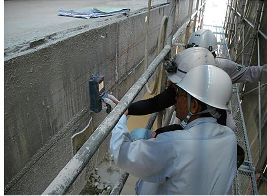
写真7 鉄筋探査
