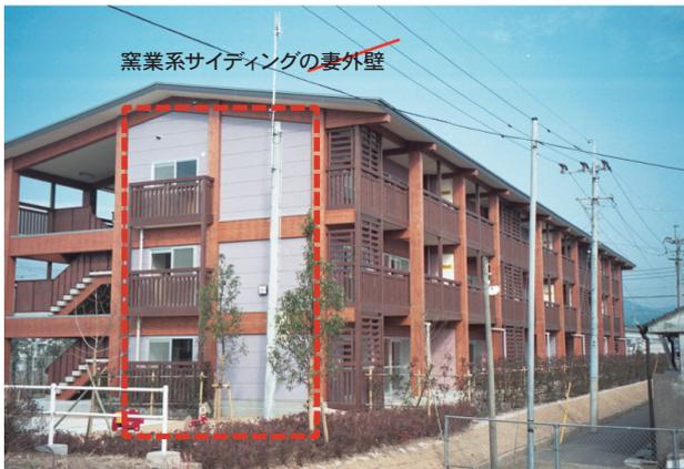
写真-1 外壁の耐久性を高めるため、妻外壁は窯業系サイディングとした事例
