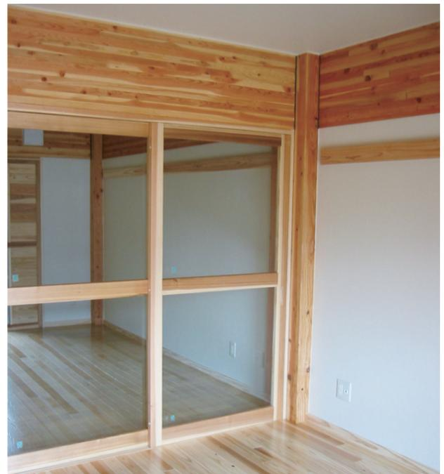
写真-3 「燃えしろ設計」により、柱・梁を室内に見せることで、木造らしさを表現した事例
