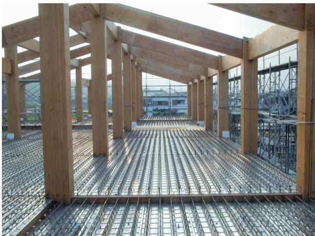
写真-2 コンクリート床を大断面集成材の柱・梁で支える住宅（工事中的写真）
